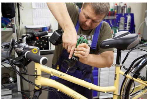
Определите место для крепления вашей аккумуляторной батареи в соответствии с её типом и особенностями конструкции рамы велосипеда. Возможно, придётся высверлить дополнительные отверстия в раме под крепёж либо воспользоваться хомутами или иными подходящим и надёжными крепёжными изделиями.
